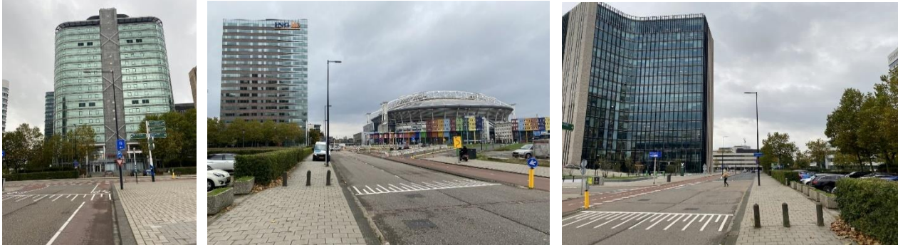
Figuur 5.7 t/m 5.9 - Huidige fietssituatie conflicteert de Dreefkavel niet
